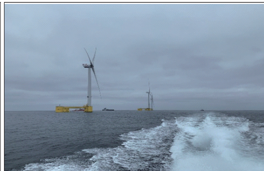
WindFloat Atlantic 25MW
